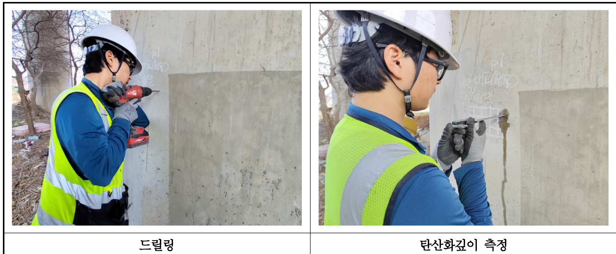
【사진 1.4.3】 탄산화 깊이 측정 현장사진
