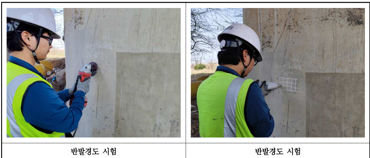
【사진 1.4.2】반발경도시험 현장사진
