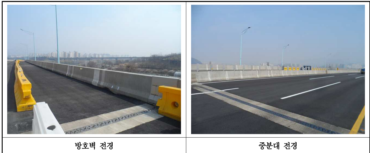
【사진 1.3.50】 방호벽 및 중분대 전경
