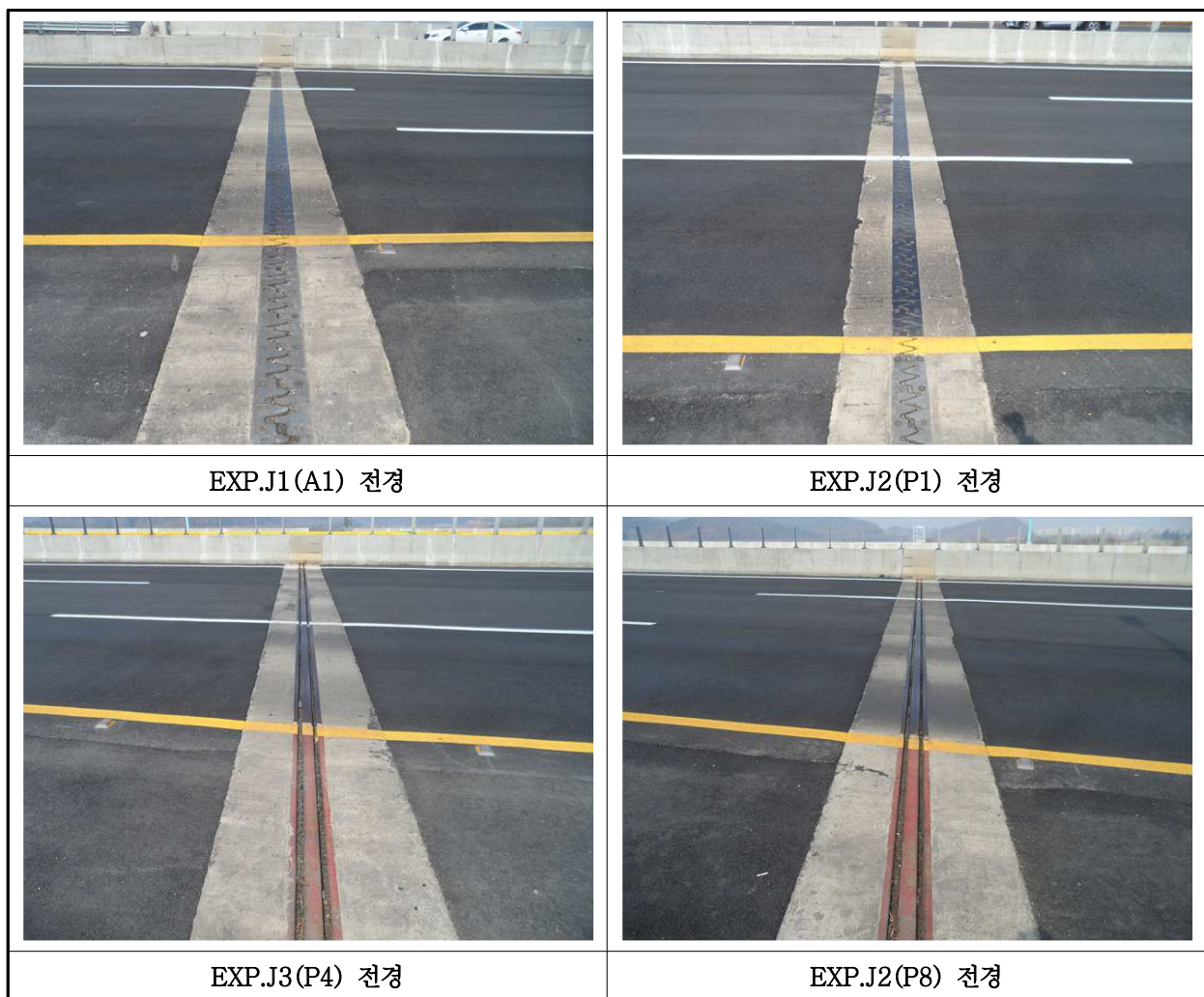
【사진 1.3.43】 신축이음장치 전경
