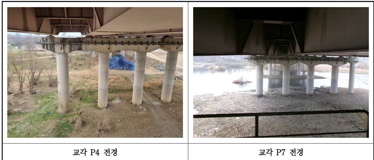
【사진 1.3.36】 교각 전경
