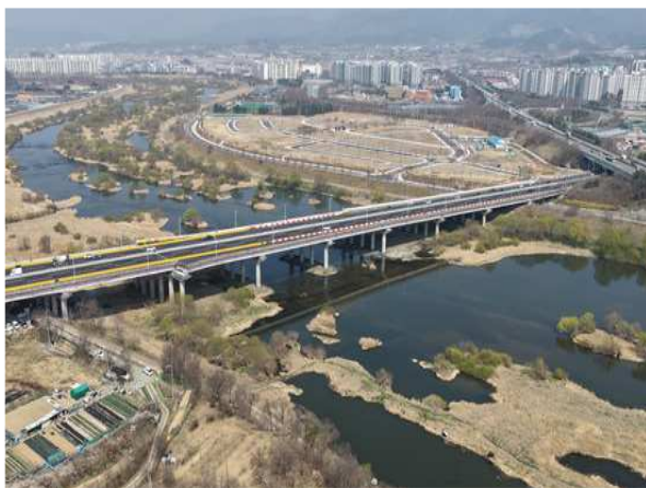
하부 교차 시설(금호강, 금호강변로) 전경
