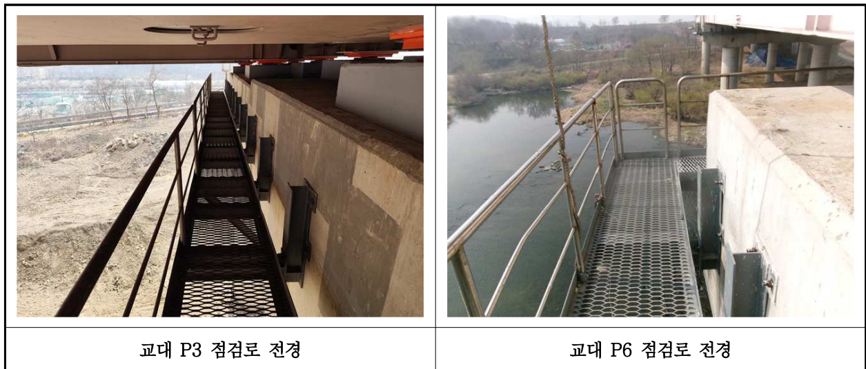
【사진 1.3.52】 교량 점검시설 전경
