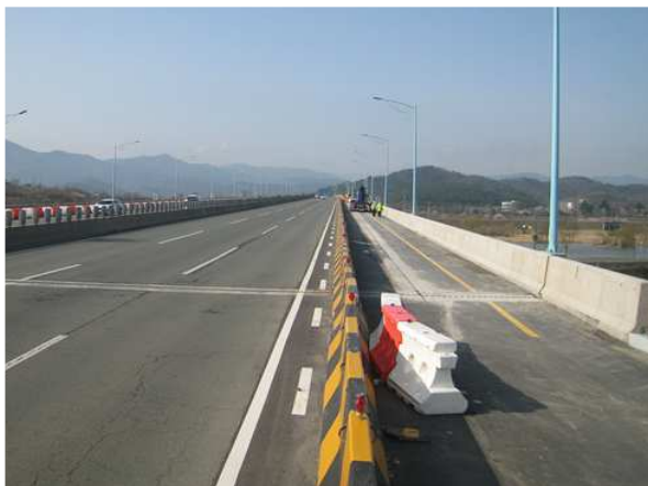
2024년 상부 범물방향 합류부 방호벽 제거구간 현황
