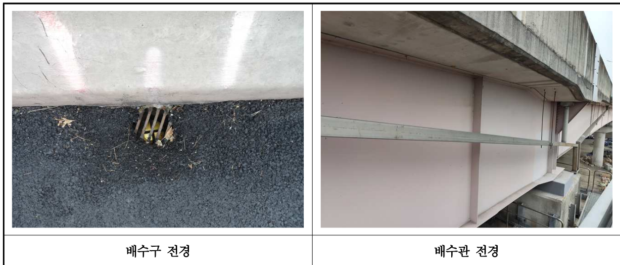
【사진 1.3.48】 배수시설 전경
