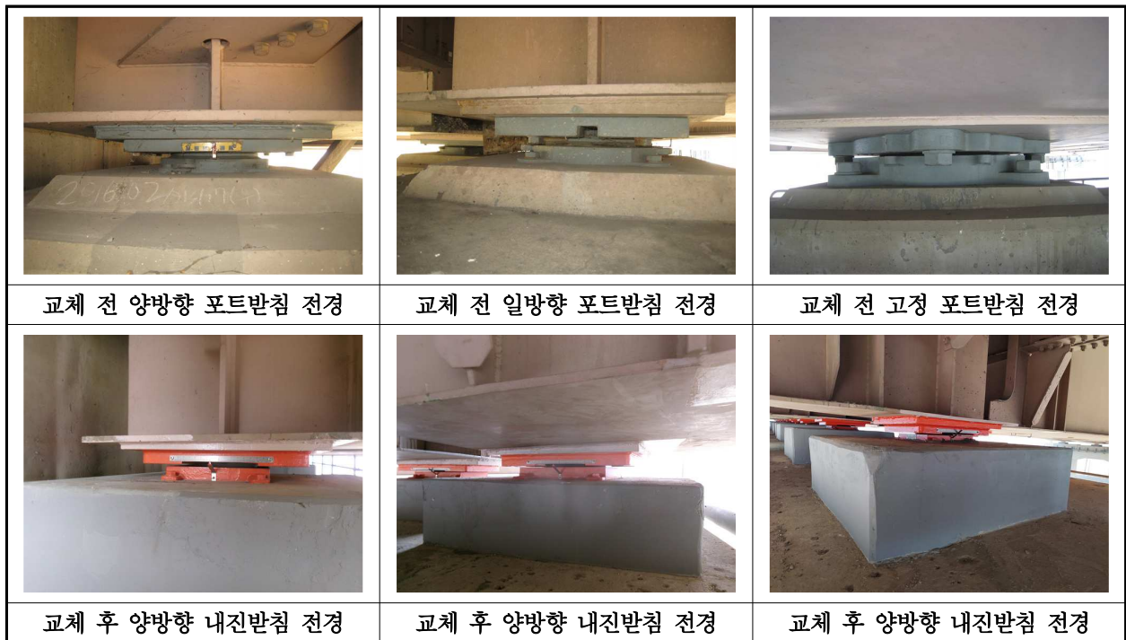
【사진 1.3.39】 교량받침 전경
