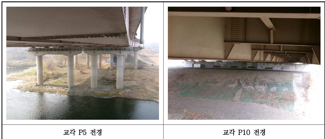
【사진 1.3.10】 교각 전경
