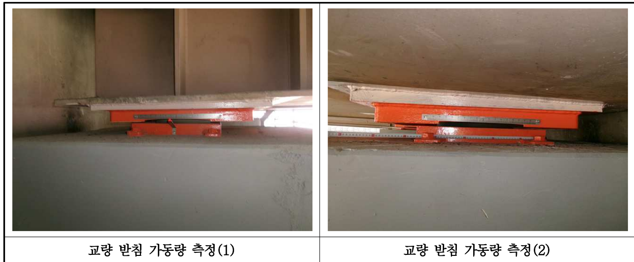
【사진 1.3.42】 교량받침 이동량 측정
