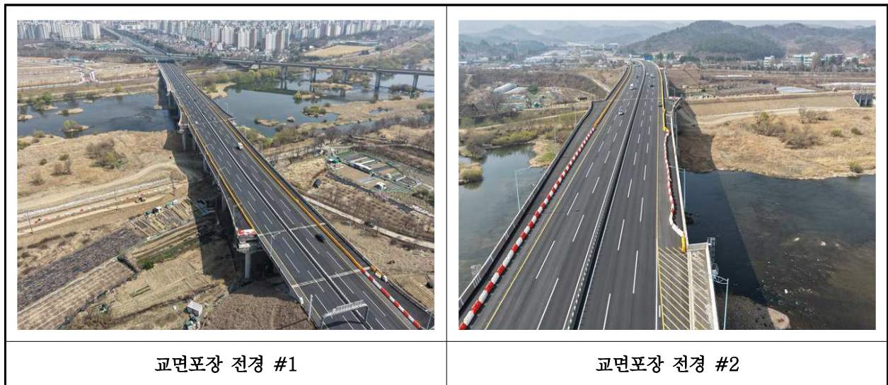
【사진 1.3.19】 교면포장 전경
