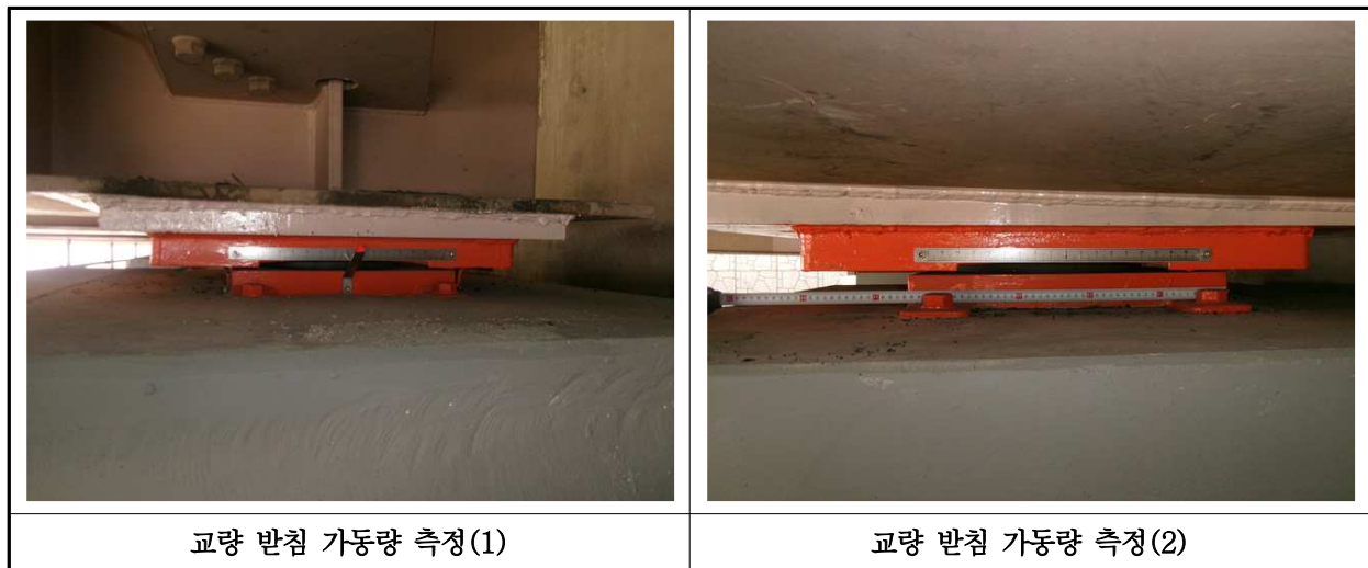
【사진 1.3.15】 교량받침 이동량 측정
