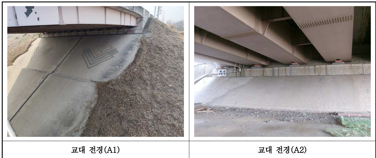
【사진 1.3.8】 교대 전경
