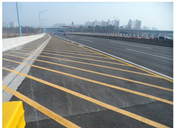
2026년 상부 범물방향 합류부 방호벽 제거구간 현황
