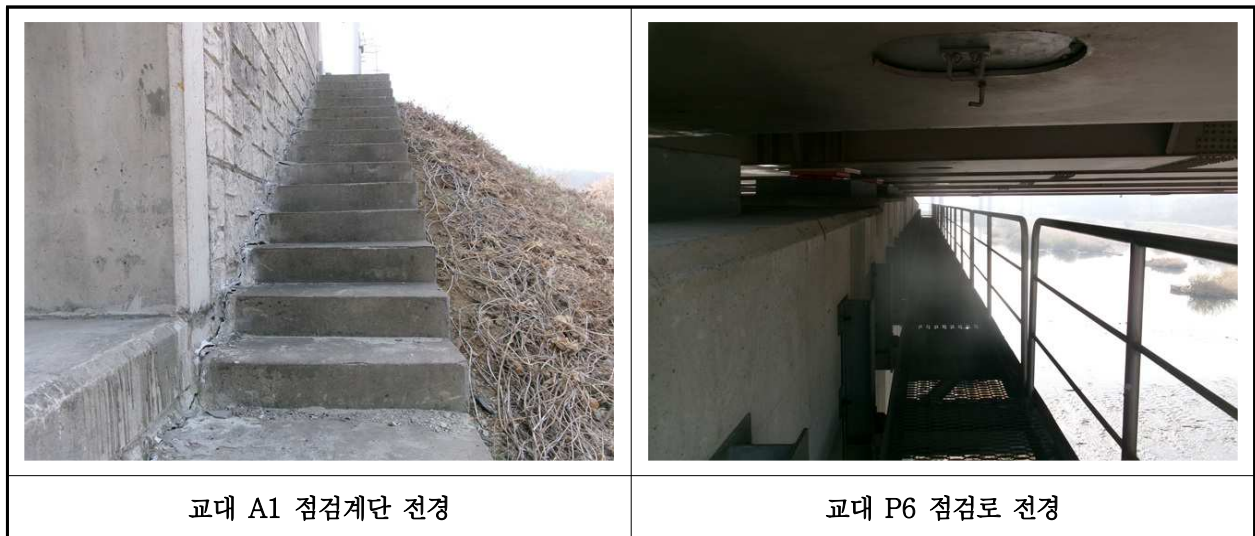
【사진 1.3.25】 교량 점검시설 전경
