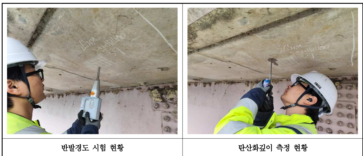
【사진 1.4.1】 콘크리트 내구성조사 현황
