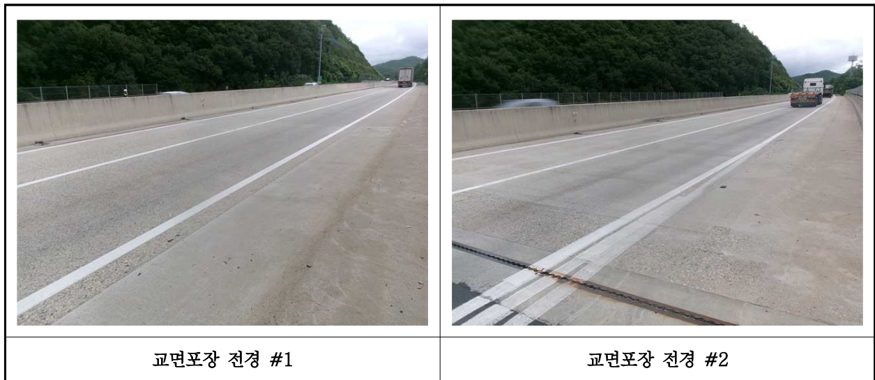
【사진 1.3.46】 교면포장 전경
