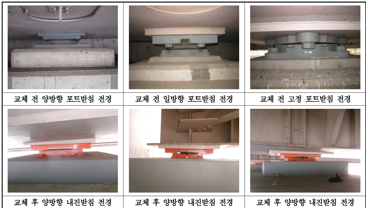
【사진 1.3.12】 교량받침 전경
