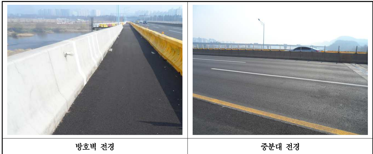
【사진 1.3.23】 방호벽 및 중분대 전경
