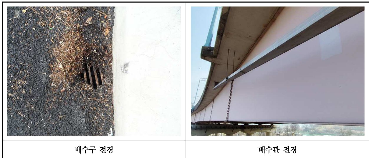
【사진 1.3.21】 배수시설 전경
