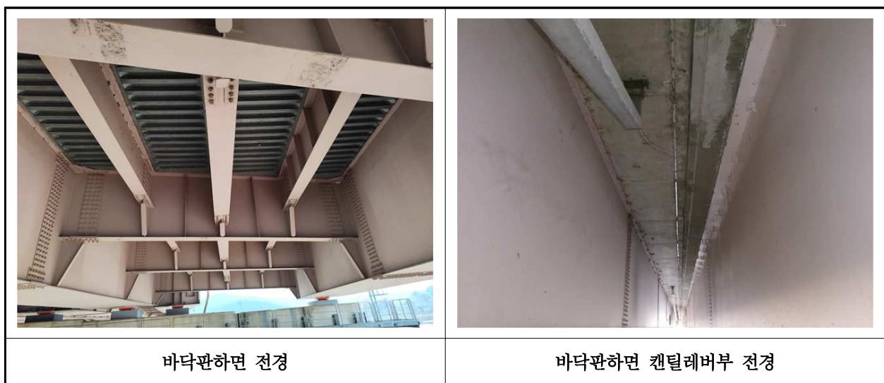
【사진 1.3.2】 바닥판하면 전경
