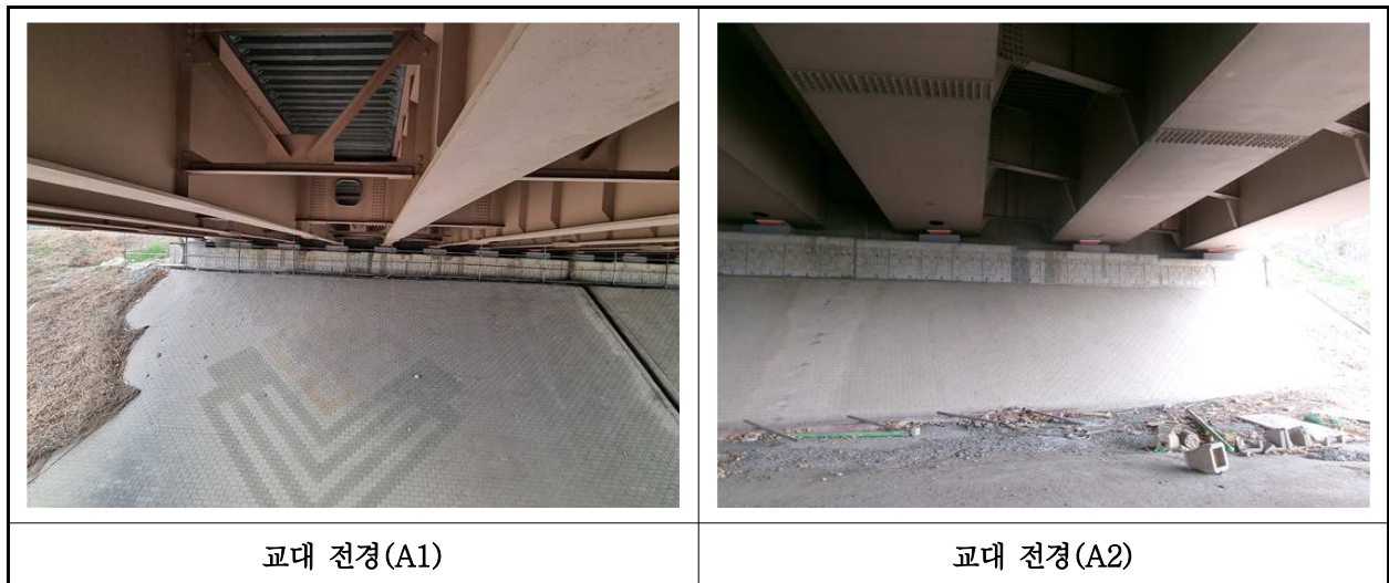
【사진 1.3.34】 교대 전경
